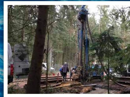
Um neue Brunnenstandorte zu bestimmen, sind zunächst Probebohrungen erforderlich.
